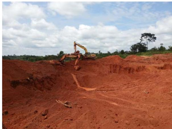
**Figure 16. Exploitation d'un gisement éluvionnaire à Kana près de Béké dans l'arrondissement de Ketté**
