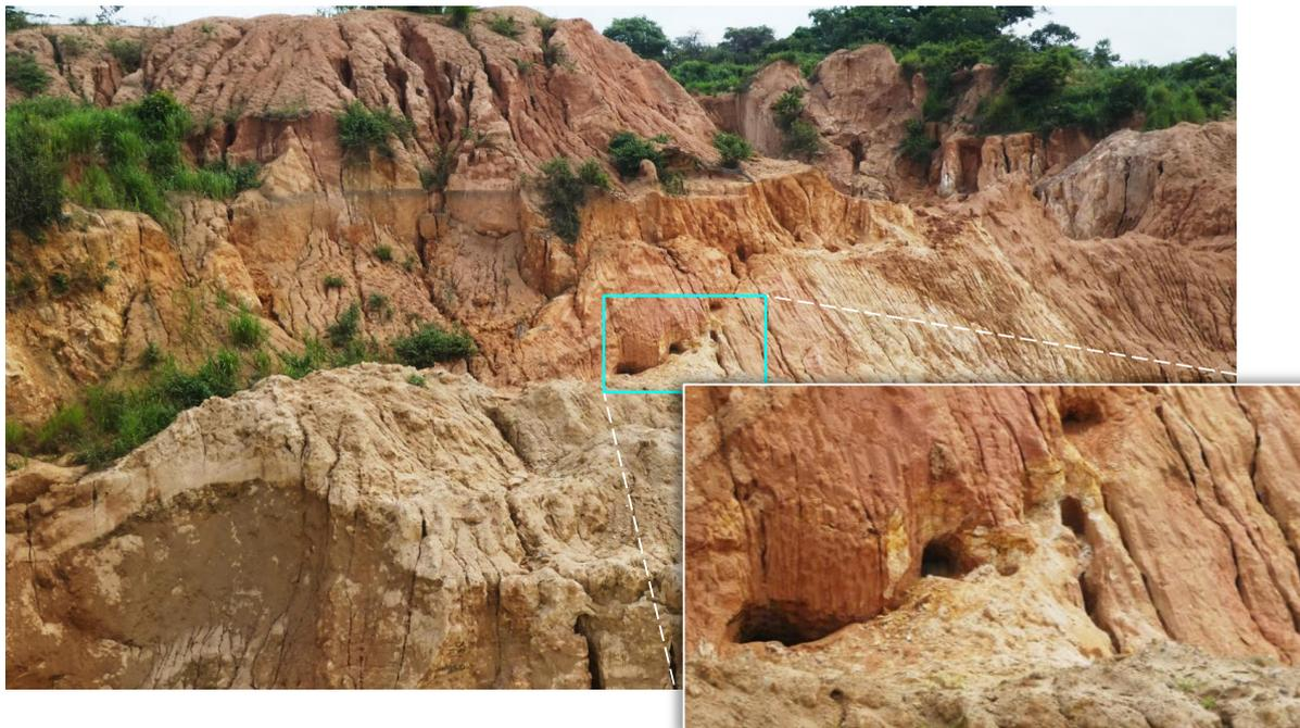
Figure 64 Vu vers l'ouest de la même carrière, exposant des excavations artisanales dans des roches altérées et faibles (MS -CM26)
